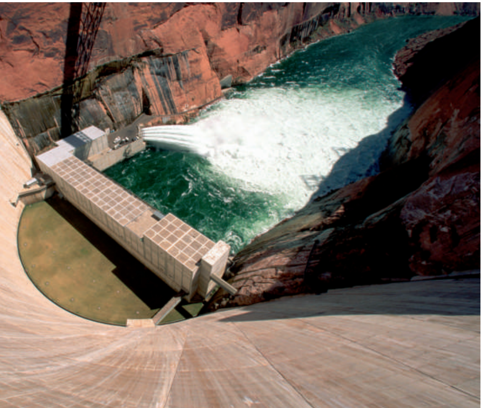
Mit der hier gewonnenen Elektrizität werden die US-Bundesstaaten Wyoming, Colorado, Utah, New Mexico und Arizona versorgt.
