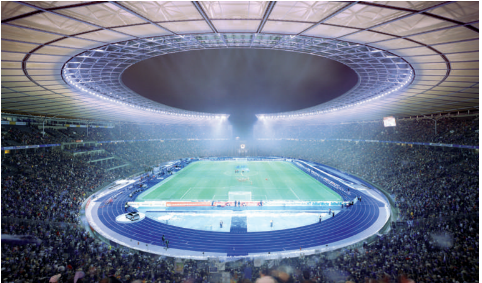
Heller, lauter und mit einem Dach für alle Zuschauer: das von Volkwin Marg umgebaute Berliner Olympiastadion.
